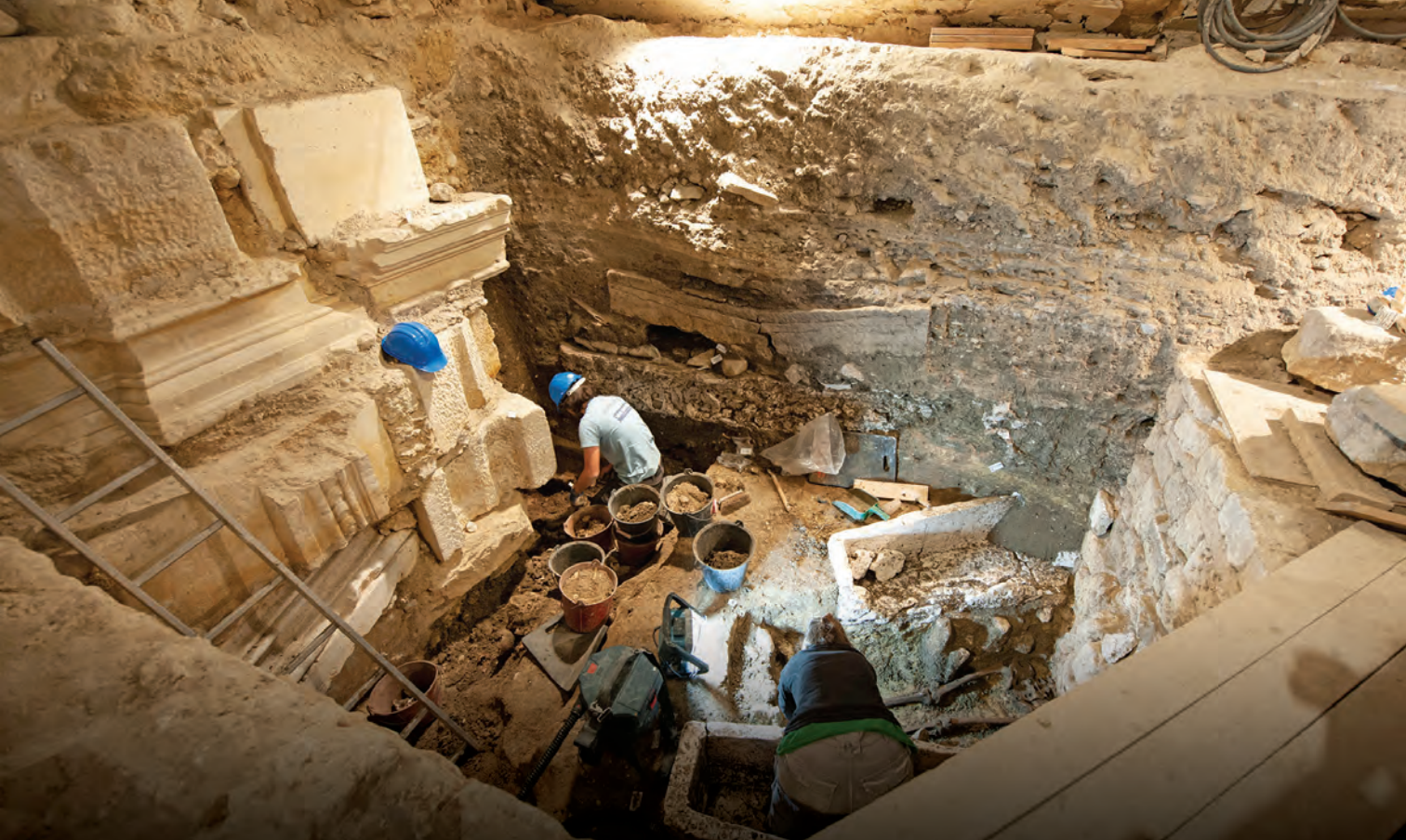
프랑스 생드니 성당의 복원 현장. 프랑스의 고고학 복원 현장은 짧게는 수십 년 길게는 수백 년의 시간을 두고 진행된다. Fouille du massif occidental de la basilique de Saint-Denis (Seine-Saint-Denis), intérieur, vaisseau central, deuxième travée, fouille des différentes structures, mars 2023. Responsable d'opération : Ivan Lafarge, Bureau du patrimoine archéologique de Département de la Seine-Saint-Denis. © Emmanuelle Collado, Inrap
