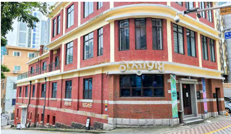
한성1918 부산생활문화센터 지하층에는 매립 이전에 쌓은 옛 축대가 남아있다 ■ 필자 촬영
