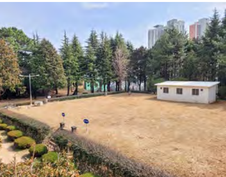
수정배수지 ■ 필자 촬영
