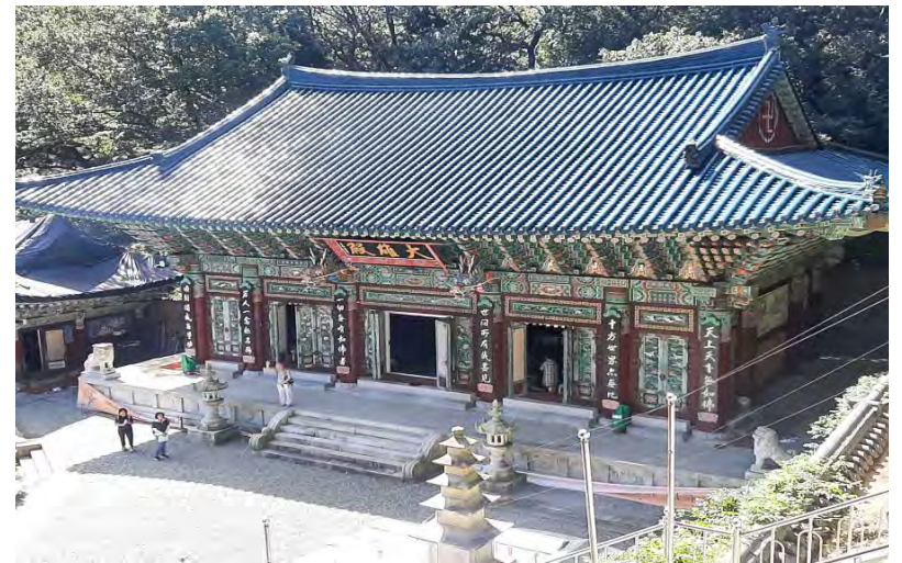
마하사 대웅전 Ⅵ 필자 촬영
